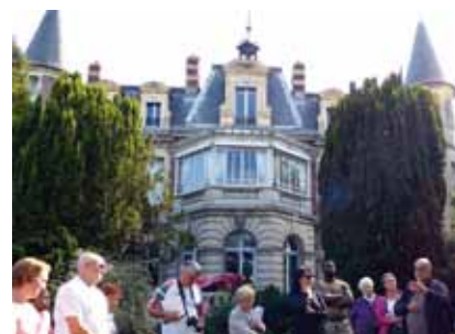
Le bâtiment des Tourelles accueillera en novembre des femmes en difficulté.
