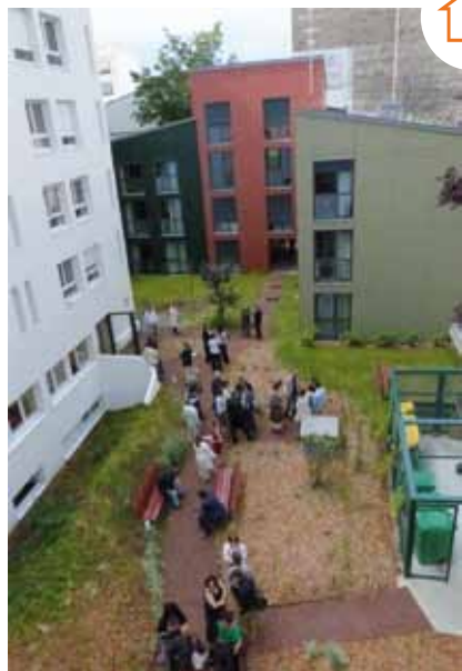
Vue sur le patio qui relie les trois structures.
