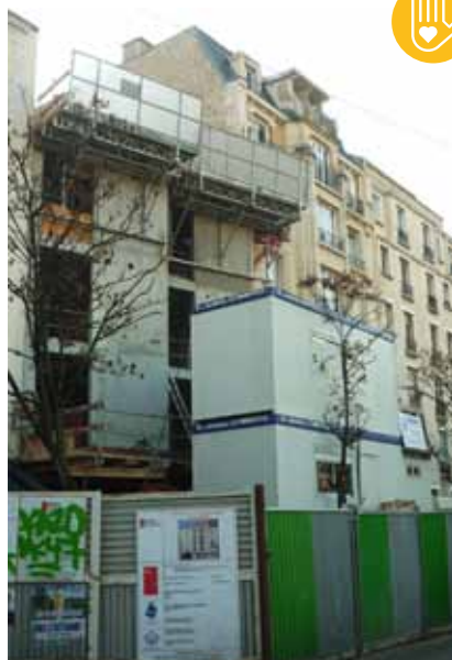
Le chantier du projet LOGIS dont Aurore assurera la gestion.
