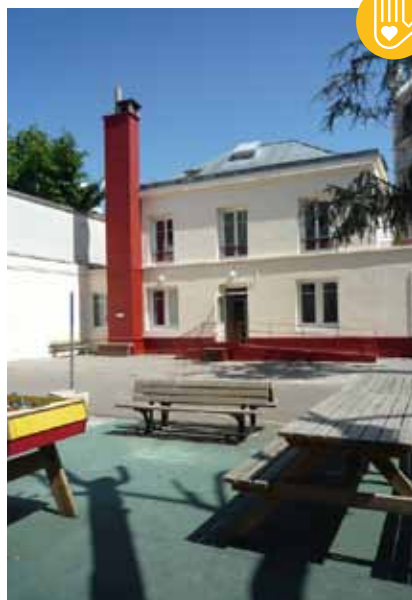
L'ITEP après sa rénovation
